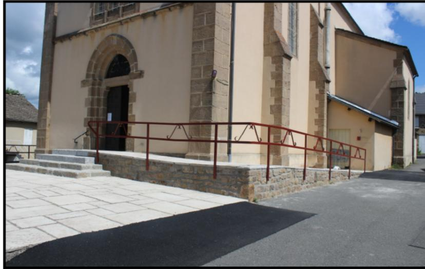
L'accès à la salle du conseil municipal à l'arrière de la Mairie, créé fin 2017, a fait l'objet de travaux d'amélioration : surélévation du mur de soutènement, stabilisation de l'espace entre le revêtement de la voie et le mur, et mise en place d'un garde-corps.
