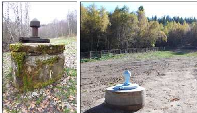
Captage de Malacombe (avant et après travaux de protection)
