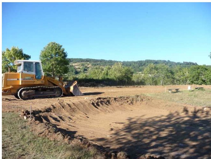
Démarrage des travaux
