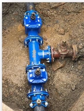
Réparation fuites d'eau : Vieille Route Sud et quartier du Fort
