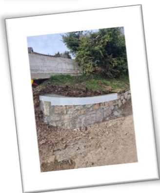
Déplacement d'un mur du domaine public, route du Crouzet
