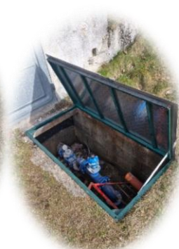
Réalisation d'une trappe d'accès aux compteurs d'eau du Ravin Blanc
