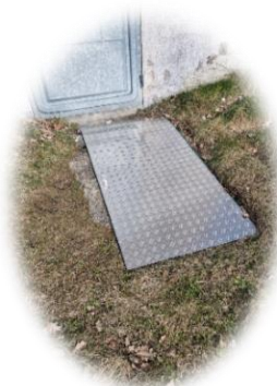
Réalisation d'une trappe d'accès aux compteurs d'eau du Ravin Blanc
