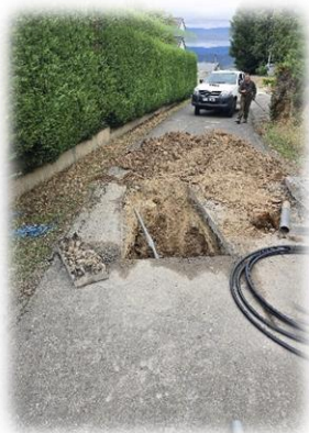
Réparation d'une fuite d'eau chemin du Planas
